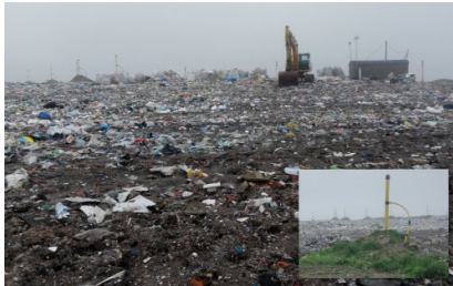
Przerwane prace przy formowaniu korony składowiska
