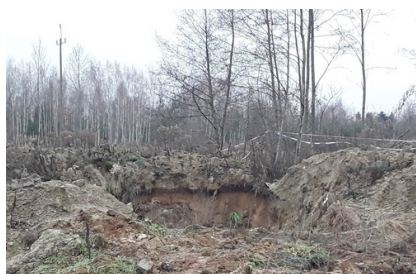
Stare Grabie - usunięcie odpadów
