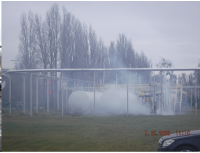
Ćwiczeniach w Zakładzie Dużego Ryzyka na terenie Warter Fuels S.A. w Płocku
