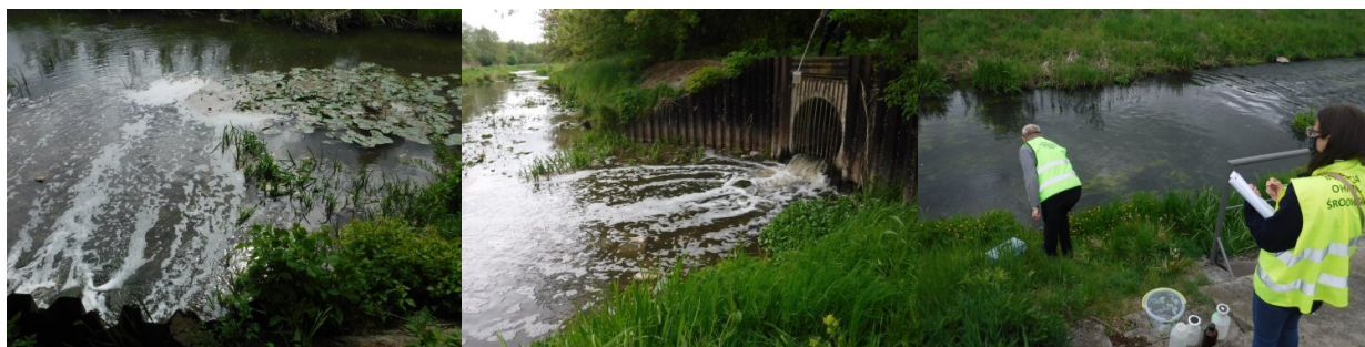
Wylot z oczyszczalni do rzeki Łydynia
