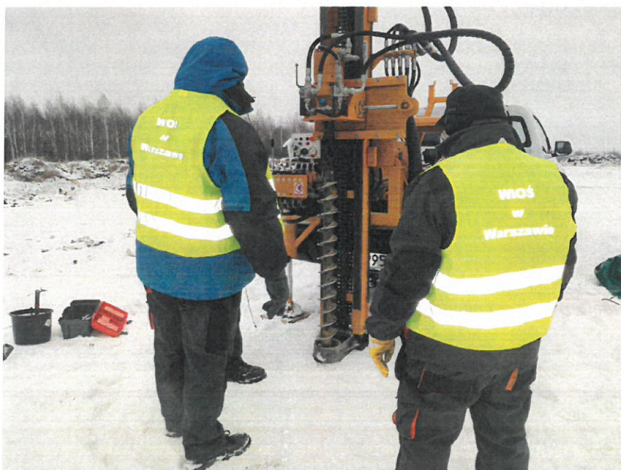
Przygotowanie do poboru próbek przez WIOŚ w Warszawie z wykorzystaniem wiertnicy samochodowej przeznaczonej do wykonywania nierurowanych otworów w gruncie metodą ślimakową zakupionej w ramach projektu POIS.03.02.00-00-001/09 „Zakupy sprzętu do szybkiej
